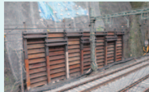
強化後(鋼鉄製・高さ5m)
