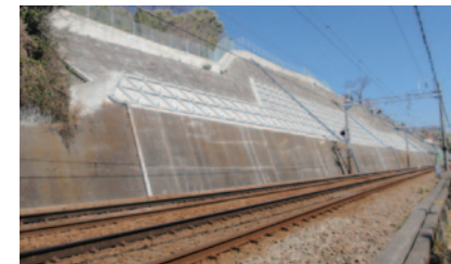
防護柵と落石検知装置を整備
