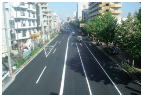
中原街道路面補修工事
