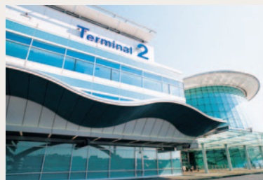
羽田空港 第2旅客ターミナルビル
