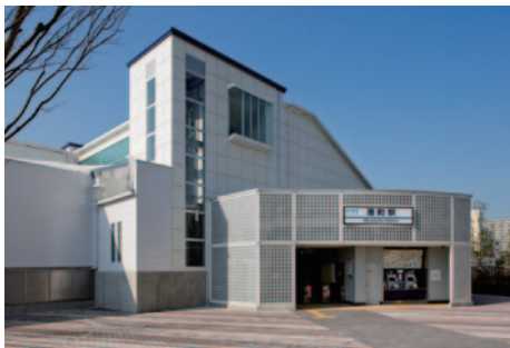
港町駅舎改修工事
