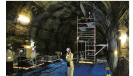
トンネルの補修工事の様子
