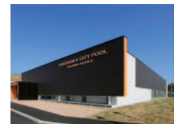
2011年4月に開業した佐島の丘温水プール
