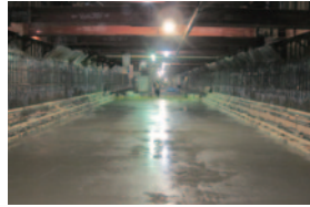
産業道路駅付近での躯体構築状況
