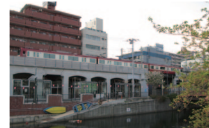
高架橋の耐震補強工事が進む
